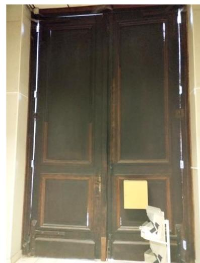
Photo n°4 : Vue de la double porte en bois côté hall d'entrée vue intérieure. Pas étanche à l'air et peu sécurisée.
