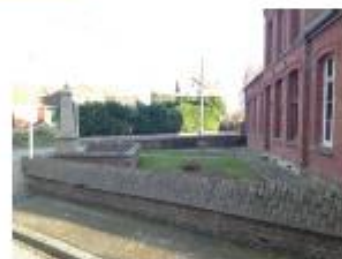
Gages - Ancienne maison communale
